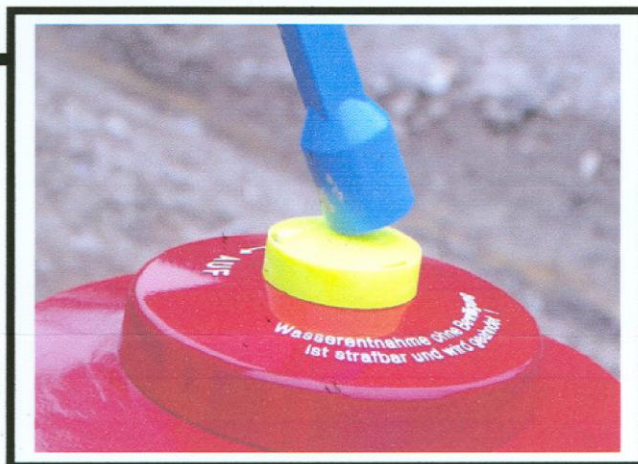
Inserimento del piombino con la chiave per idranti
