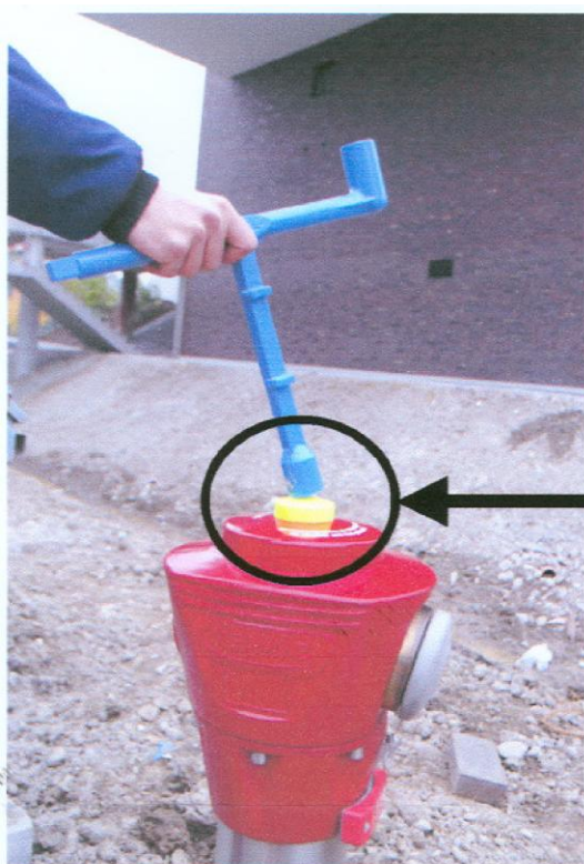
Einschlagen der Plombe mit dem Hydranten Schlüssel
